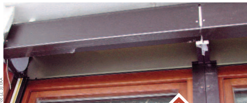
➤ 1 Budowa rolety zewnętrznej zintegrowanej z moskitierą
